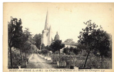
↳ VUE SUR LA CHAPELLE DU CHÂTEAU, XIV e SIÈCLE
